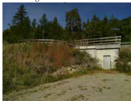
Der Eingang zu den Hochbehältern
