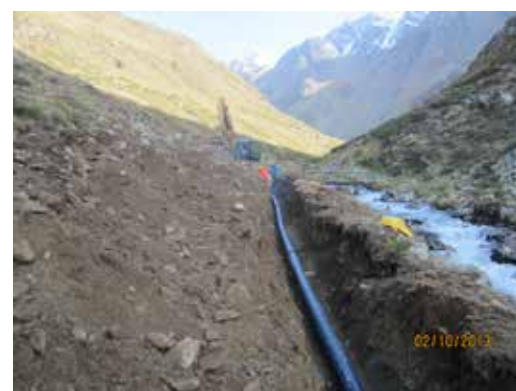
Verlegung der neuen Trinkwasserleitung von den Knottbergquellen
