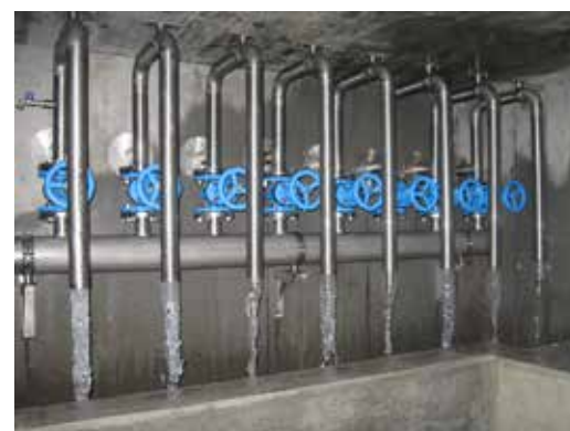
Zulauf aus den Orglesquellen zum Sammelschacht
