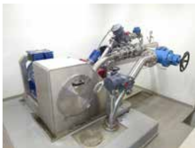
Die Turbine des Trinkwasserkraftwerkes am Eingang zur Spinai (maximale Leistung = 88 kW)
