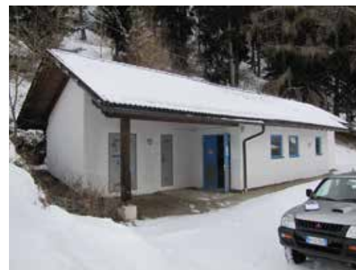
Gebäude der Marktgemeinde Mals in Planeil mit Zusammenführung, Entsäuerung und energetischer Nutzung des Wassers aus den Orgles- und Knottbergquellen
