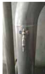
Probehahn zur Entnahme für Laboranalysen
