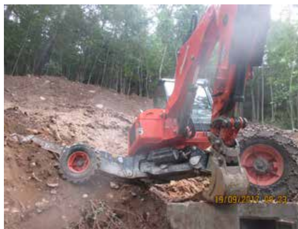
Der Schreitbagger beim Freilegen der Quelle (links)
