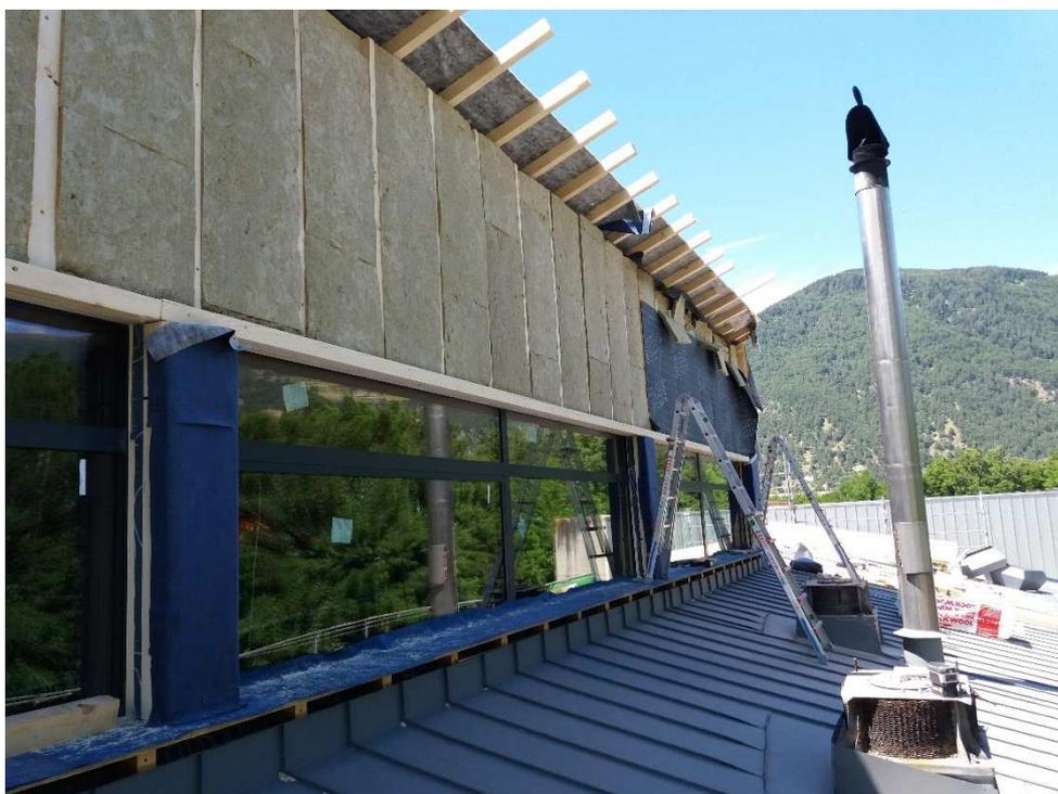
**Abbildung 6: Dämmarbeiten an der Gaube am Nordflügel**
