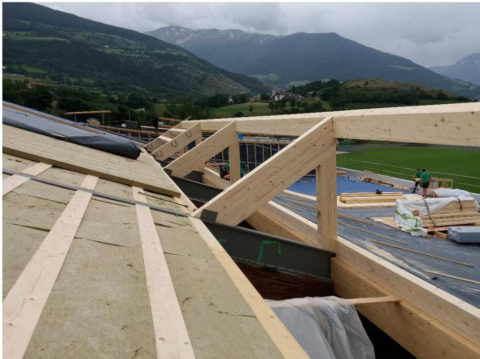
**Abbildung 5: Dämmarbeiten am Südflügel**
